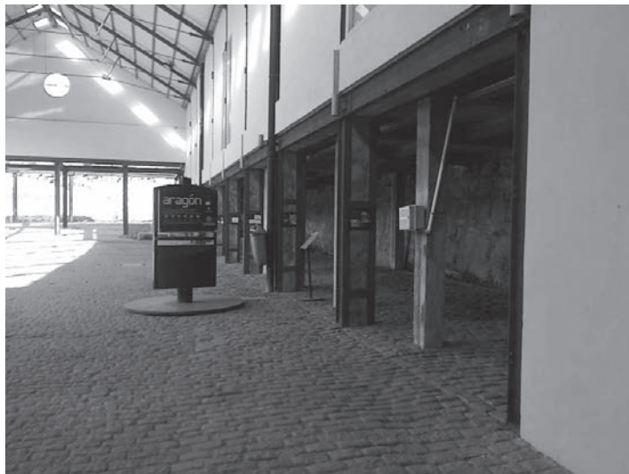
Figura 34. Tramo de muralla en el Museo de las Migraciones
