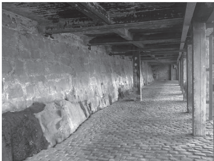
Figura 35. Tramo de muralla en el Museo de las Migraciones
