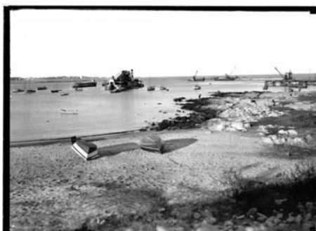
Playa comprendida en el tramo correspondiente a la rambla Sur —probablemente la de Santa Ana—, desaparecida tras su relleno durante las obras de construcción de la rambla. Al fondo, la construcción del muro de contención (1923-1935 aproximadamente). Fuente: Centro de Fotografía de Montevideo, IM, foto 18622FMHGE.CMDF.IMM.UY, disponible en < http://cdf.montevideo.gub.uy/fotosexposicion/3590?page >
