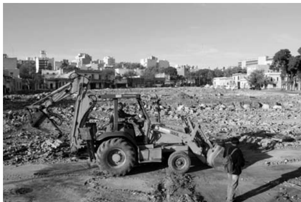
Predio demolido para la construcción del parque urbano Liber Seregni. Foto tomada de la IMM. Agenda Montevideo. Nuevos Espacios Urbanos-Parque General Liber Seregni. Disponible en: < http://agenda.montevideo.gub.uy/proyecto/686 >
