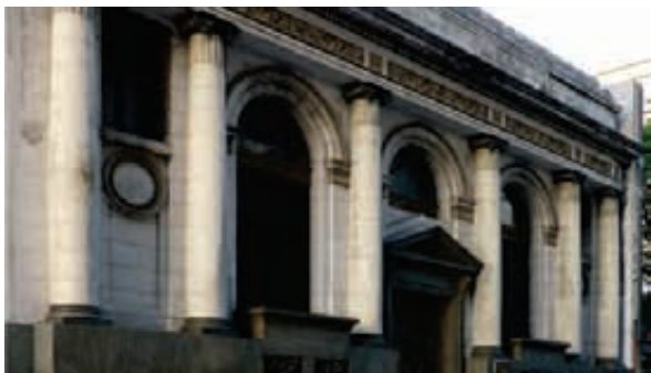
Vista de fachada calle Zabala
