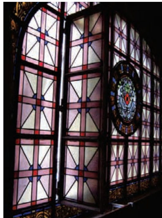
Detalle de apertura del vano
