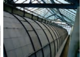
Vista interior de la claraboya
