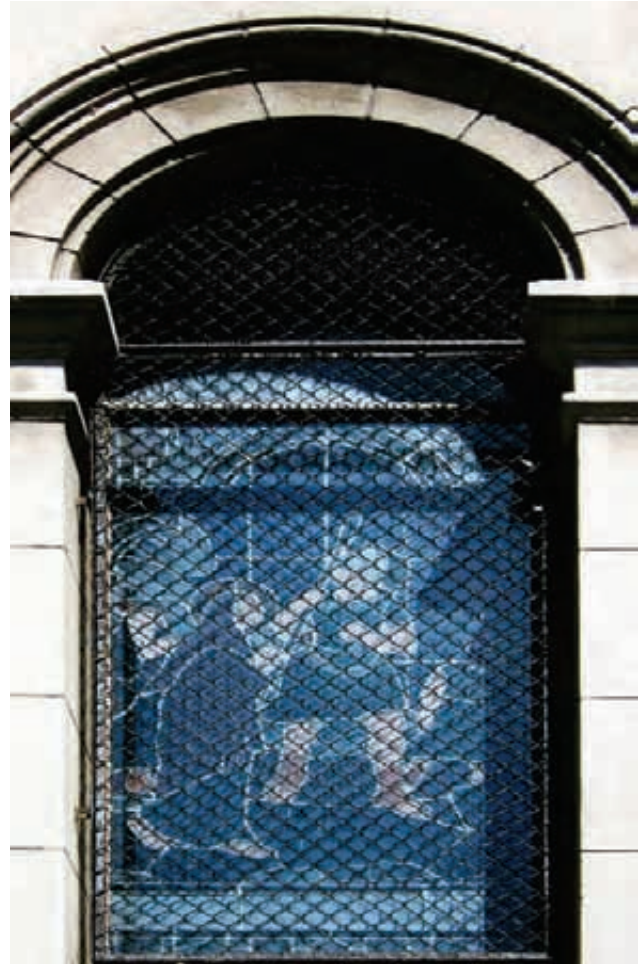
80. Grilla de protección. Iglesia San Juan Bautista, Montevideo.
