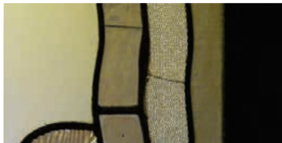
Fractura de vidrios
