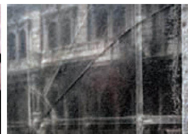
Vidrio de protección roto
