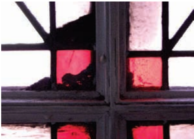
74. Detalle de estructura en perfiles metálicos «T». Edificio y Cine Rex, MHN. Montevideo.
