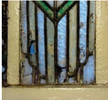
Resecamiento de la masilla
