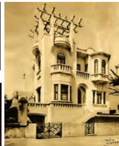
Vista fachada Bulevar Artigas (foto de archivo)
