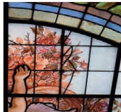
La incorporación de tramos de plomo para reparar vidrios fisurados introduce nuevas líneas oscuras que modifican y distorsionan el diseño original.
