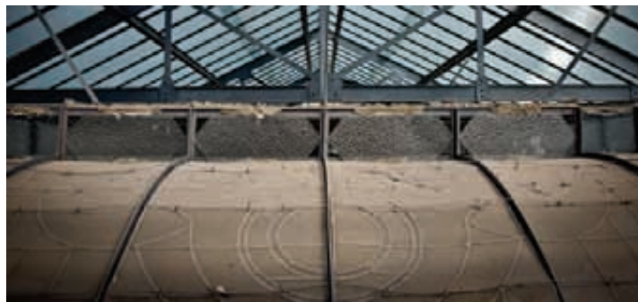
Vista interior de la claraboya
