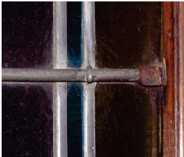
78. Detalle de varilla de armadura en vitral de puerta. Palacio Santos, Montevideo.
