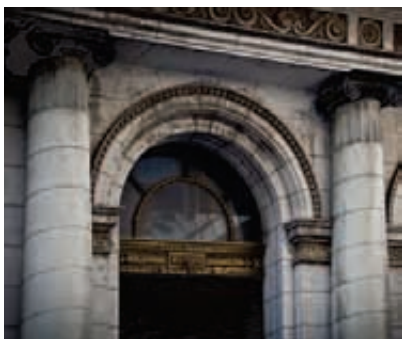
Detalle de fachada
