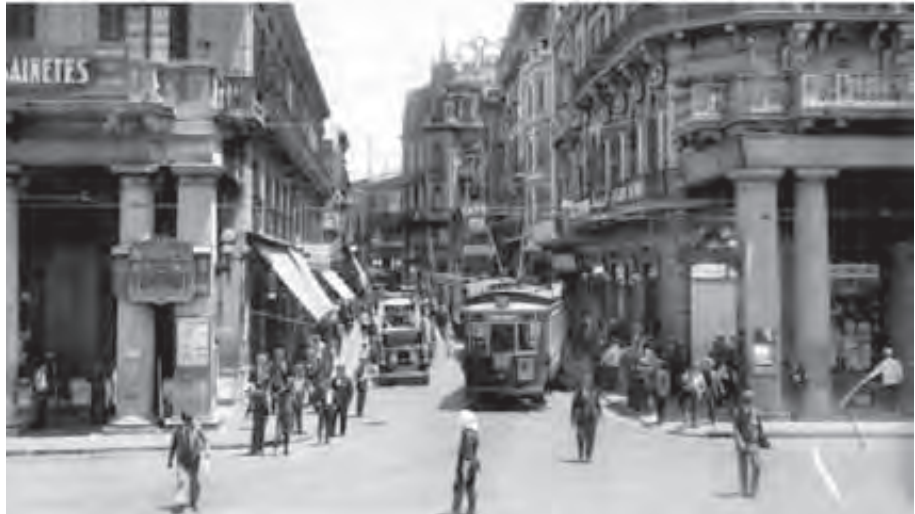
[7/15] Circulación, calle Sarandí y Juncal, 1930.
