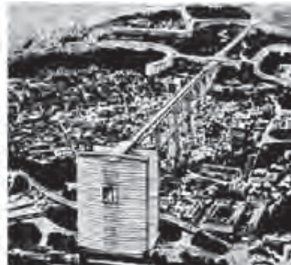
[3/39] Etapa 2: Construcción de viviendas.
