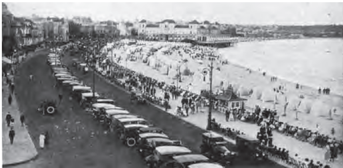
[2/51] Instalaciones para baños, Pocitos.
