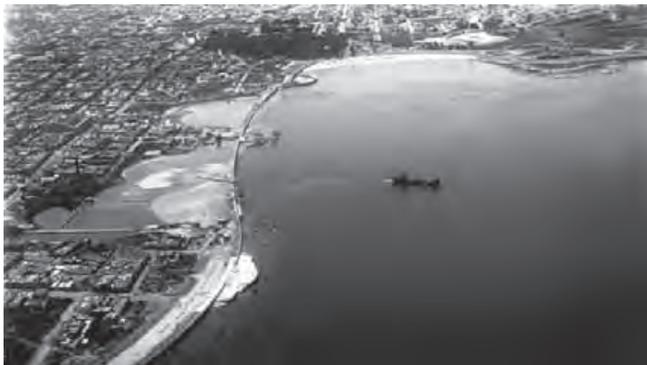
[2/62] Rambla sur. Operaciones de relleno en las playas de Santa Ana y de Patricio.
