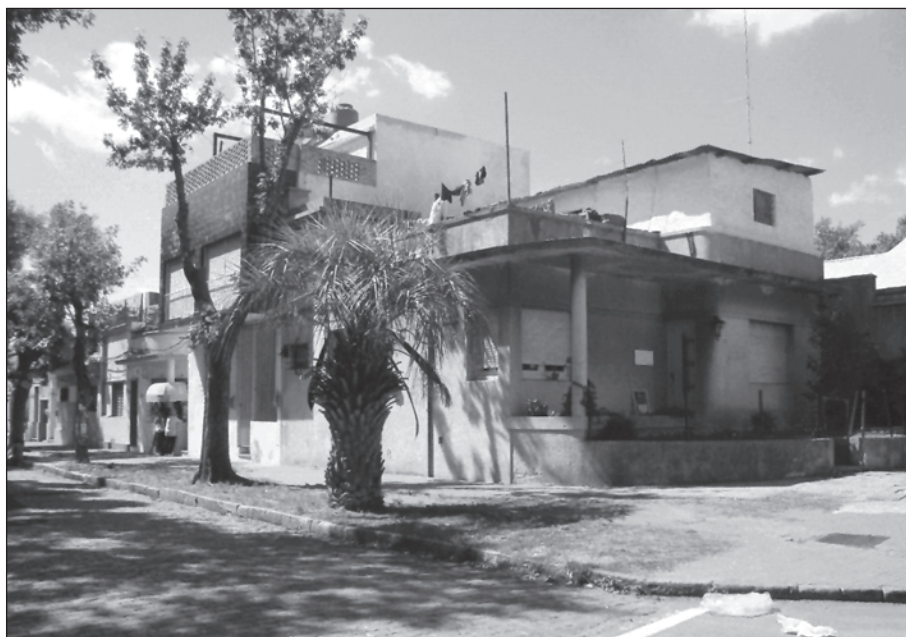
Figura 43. Ampliaciones y escaso mantenimiento se reiteran en el barrio.
