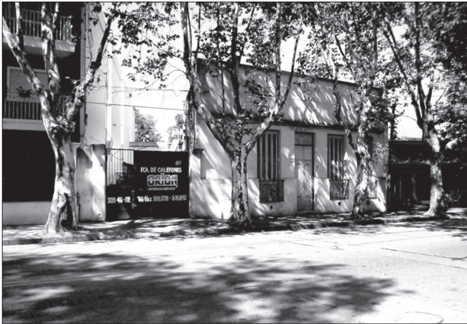
Figura 23. Vivienda estándar, actualmente destinada a fábrica.
