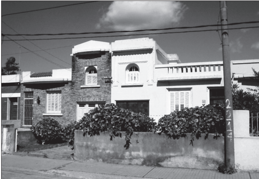
Figura 34. El sector urbano de pasajes se caracteriza por la heterogeneidad de las construcciones. Conjunto de dos casas en pasaje Denis. La modificación de la fachada de una de las viviendas desvirtúa la calidad arquitectónica del conjunto original.
