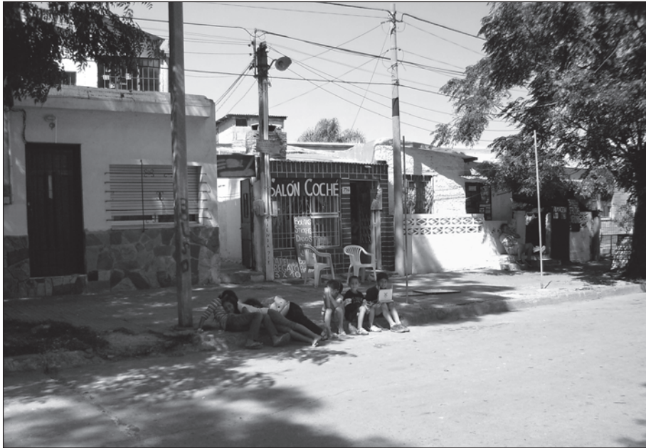
Figura 26. Comercios de pequeña escala se localizan en construcciones precarias en retiros.
