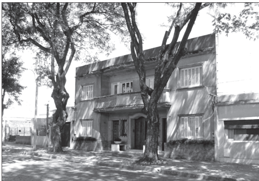
Figura 45. Edificio de apartamentos de la década del cincuenta.
