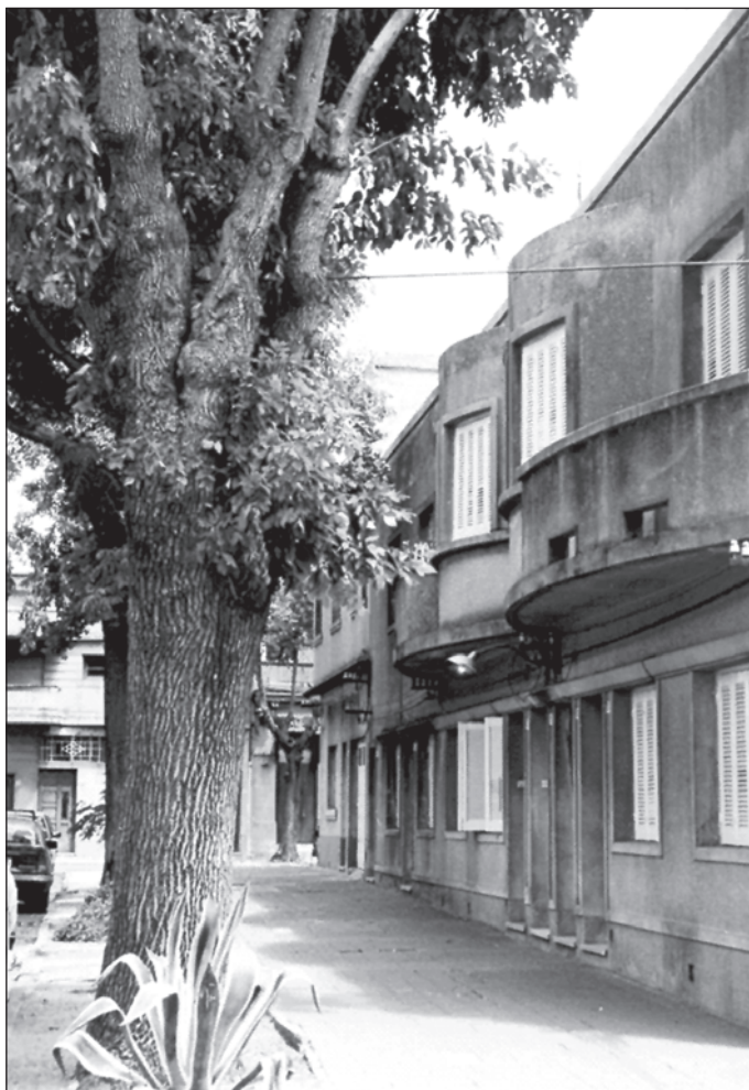
Figura 25. Conjunto de viviendas. Foto: Alberto Marcovecchio, 2000
