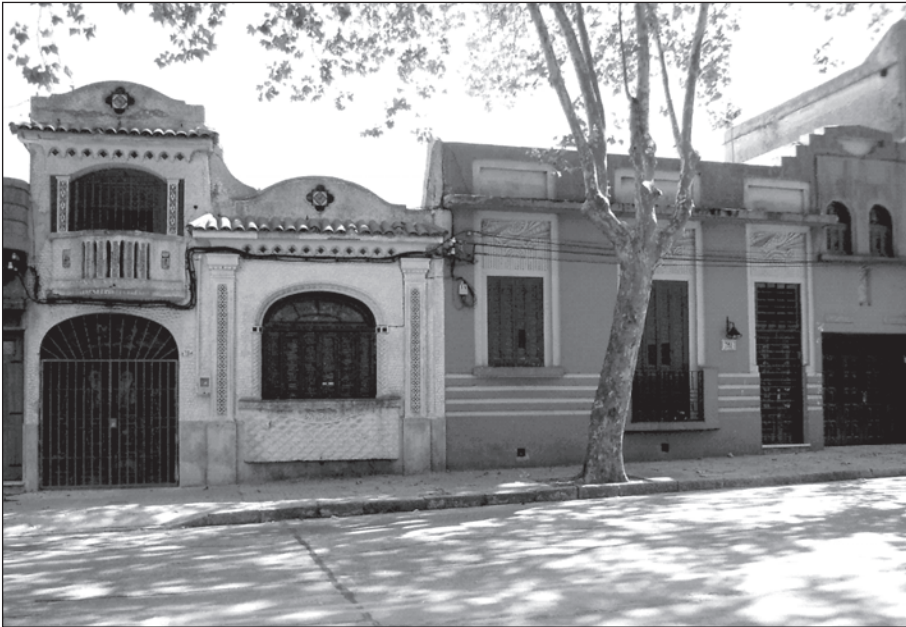
Figura 37. Viviendas frente al parque Capurro. Foto: J. Yolanda Boronat, 2011
