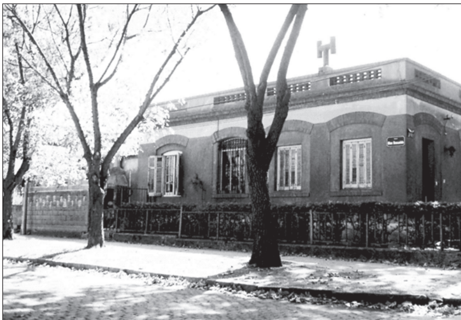
Figura 18. Esquina: Blas Basualdo y Capurro. Conjunto de viviendas presumiblemente construidas para la renta como viviendas de veraneo en el entorno de 1920.
